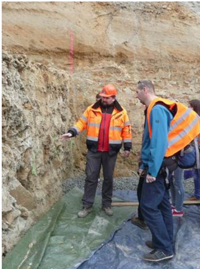
Vysvětlování průběhu tektonické poruchy v místě náspu.
