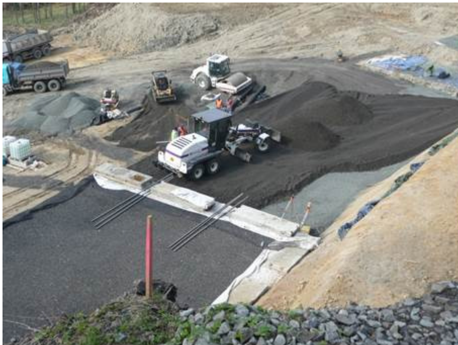
Celkový pohled na založení nového násypu
